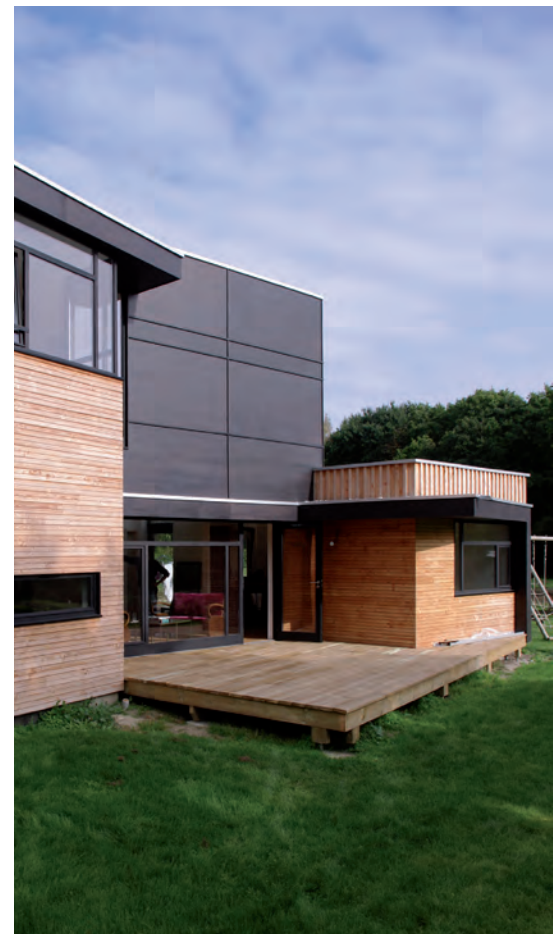
© Maison Balck & Wood, © Atelier Rubin Architectes
