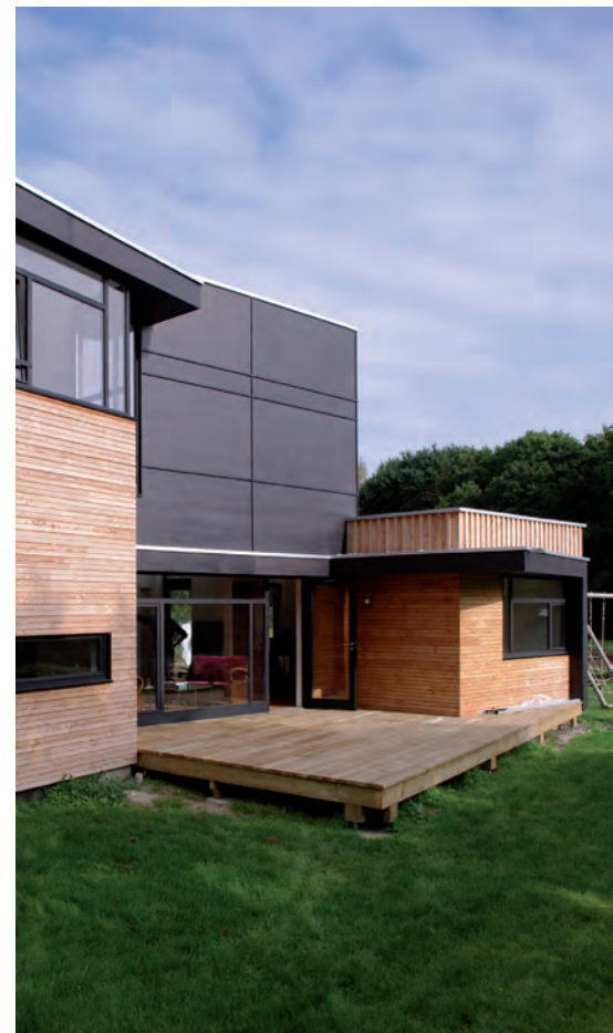
© Maison Balck & Wood, © Atelier Rubin Architectes
